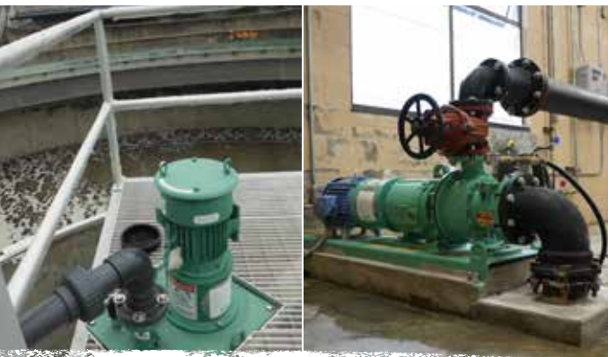
Espuma de Clarificador Primaria
